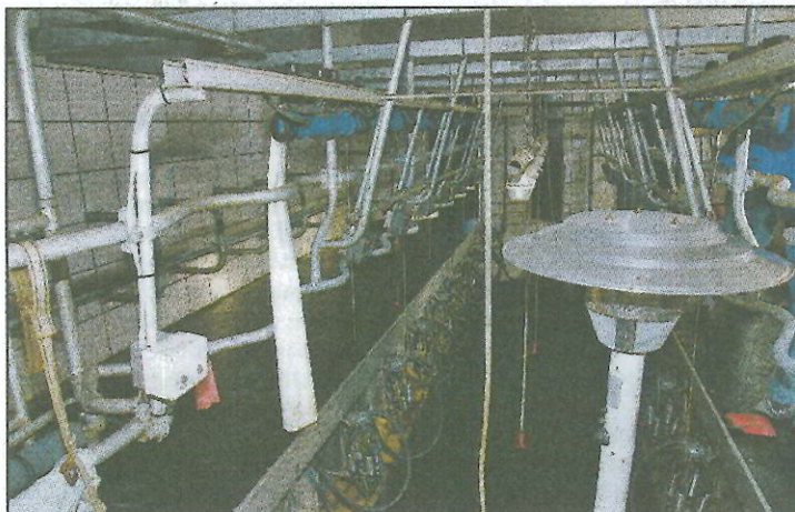
Familie Braun milcht in einem steil gestellten 2 x 8-Fischgrätmelkstand mit Abnahmeautomatik. Bei Bedarf sorgt der Heizpizl für Frostfreiheit. Kühe und Melker stehen auf Gummimatten.
